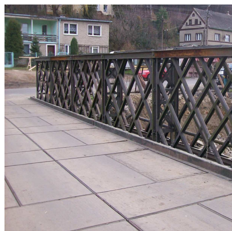
Rys.2. Konstrukcja nawierzchni Mostu DMS-65 z płyt ortotropowych: a) Widok na płytę w przekroju poprzecznym; b) sposób ułożenia płyt na pomoście (fot. K. Drozdowska).
