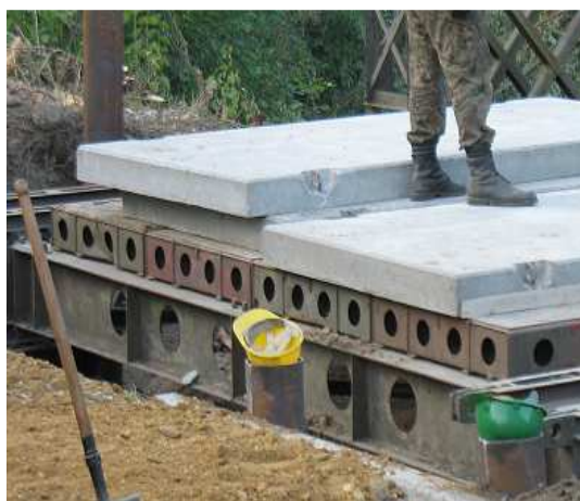
Rys.2. Konstrukcja nawierzchni Mostu DMS-65 z płyt ortotropowych: a) Widok na płytę w przekroju poprzecznym; b) sposób ułożenia płyt na pomoście (fot. K. Drozdowska).
