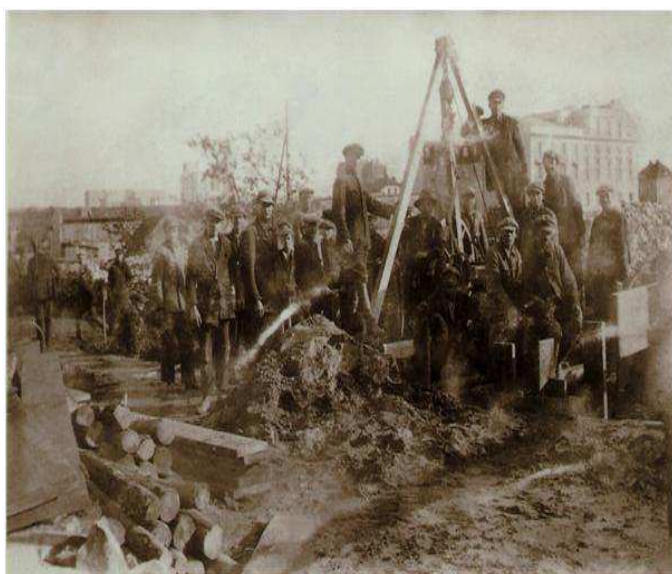
Rys. 1. Budowa ujęcia „Jana z Kolna”, 1924 rok Źródło: materiały wewnętrzne PEWIK Gdynia Sp. z o.o.
