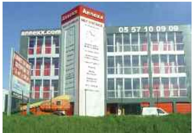
Fot. 2. Budynek firmy świadczącej usługi self-storage w Bordeaux (Francja). Źródło: WWW.wikipedia.pl
