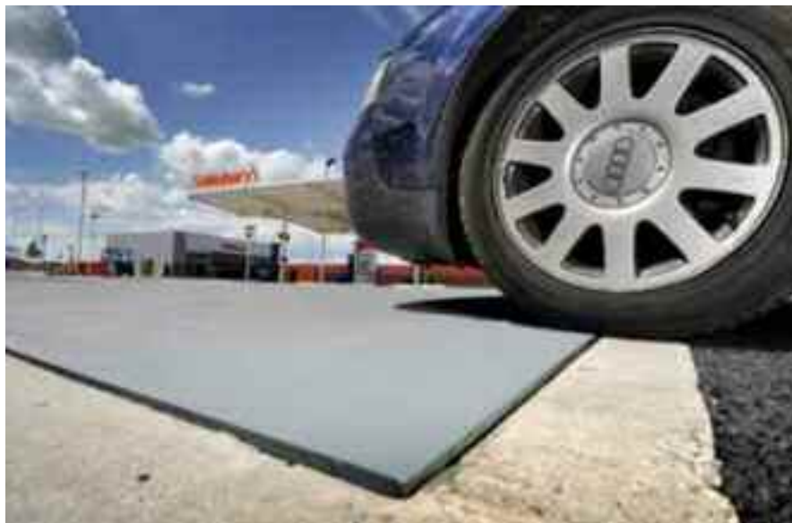
Fot. 1. Płyta kinetyczna na parkingu przed supermarketem Sainsbury's w Gloucester (fot. Internet).
