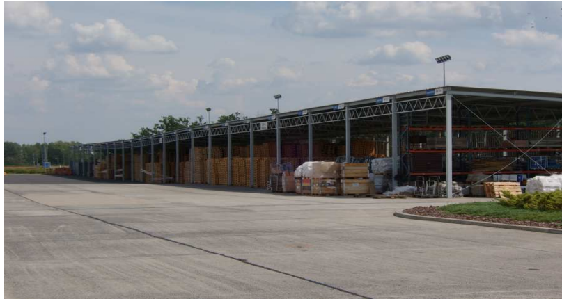
Fot.12. Wiaty na uszkodzone palety
