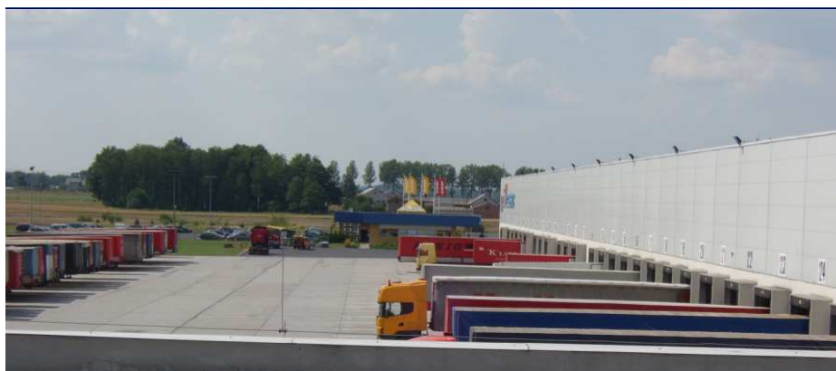
Fot.10. Parking wewnętrzny w centrum logistycznym
