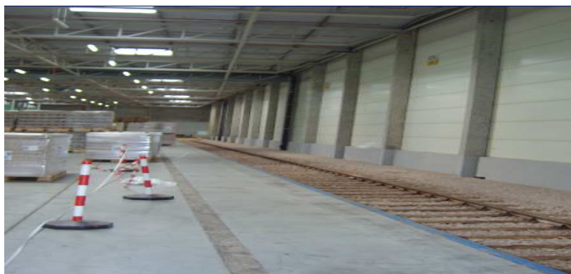
Fot.9. Towar gotowy do załadunku na wagony kolejowe
