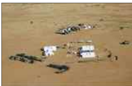
Fot. 2. Początek budowy bazy logistycznej w Czadzie (źródło: zbiory własne).
