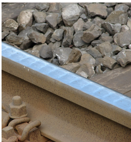
Rys. 3. Przykład falistego zużycia powierzchni tocznej szyny oraz sposób jego matematycznego opisu w programie symulacyjnym
