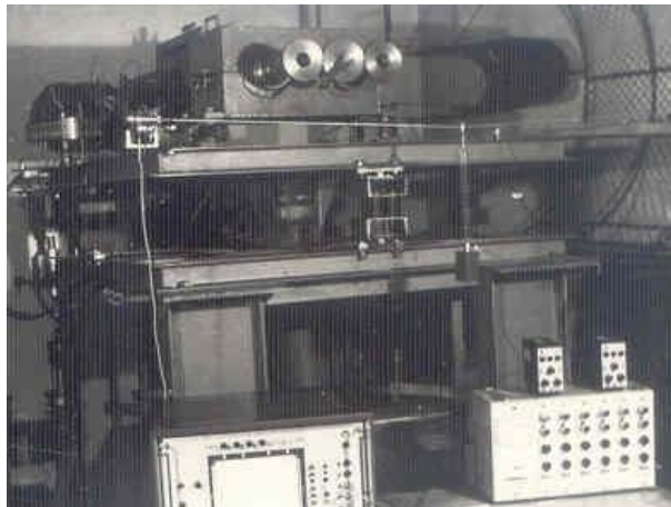
Rys. 4. Stanowisko do badań wibroizolatorów.
