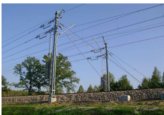
Rys. 1. Standardowe zasilanie silników trakcyjnych w Polsce napięciem 3 kV DC, ale w Europie są aż 4 różne systemy kolejowej trakcji elektrycznej (3kV/ 15kV/ 25kV, prąd zmienny/stały, różne konstrukcje sieci)
