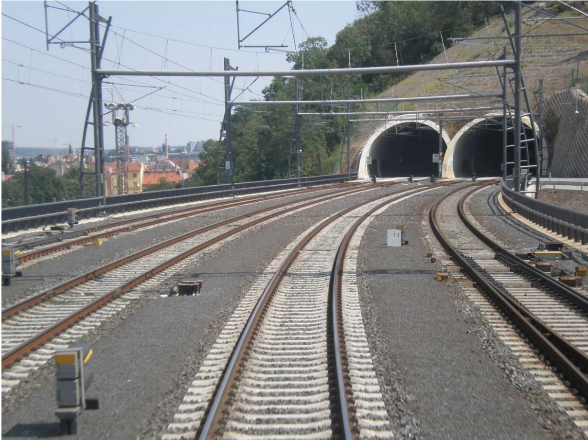
Rys. 2. Przebudowany węzeł kolejowy w Pradze.
