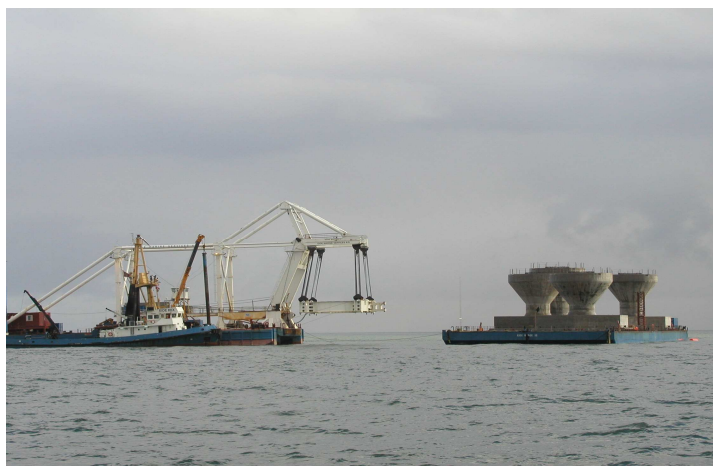
Rys. 1. Transport podstaw pod morskie elektrownie wiatrowe.
