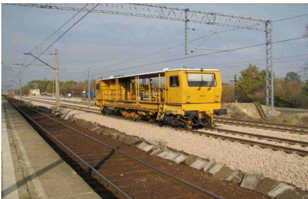
Rys.10 Dynamiczny stabilizator toru podczas pracy
