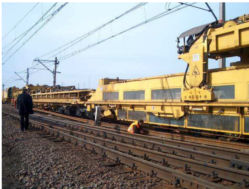
Rys. 2 Demontaż pojedynczych przytwierdzeń w tzw. „akwarium”
