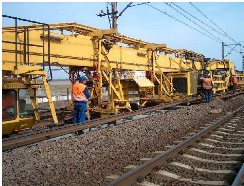
Rys. 6 Stanowisko zakładania przekładek izolacyjnych
