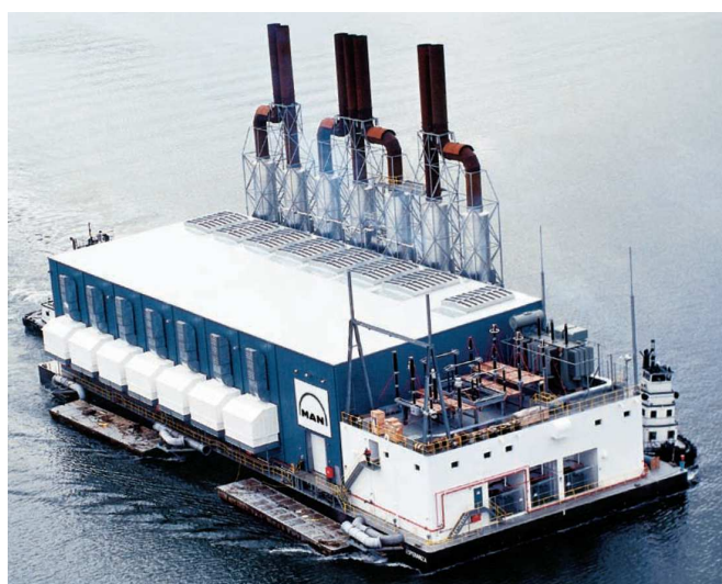
Rys. 1. Przykład transportu do Gwatemali elektrowni o mocy 124MW na barce pływającej „Esperanza”. Źródło: [1]
