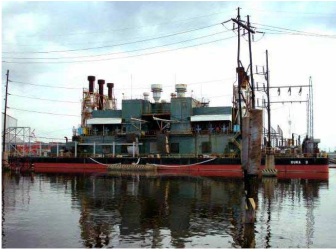
Rys. 3. Elektrownia na barce pływającej „Dura II” o mocy 66MW znajdującej się w Manili na Filipinach. W siłowni zastosowano silniki z zapłonem samoczynnym firmy Sulzer. Źródło: [2].
