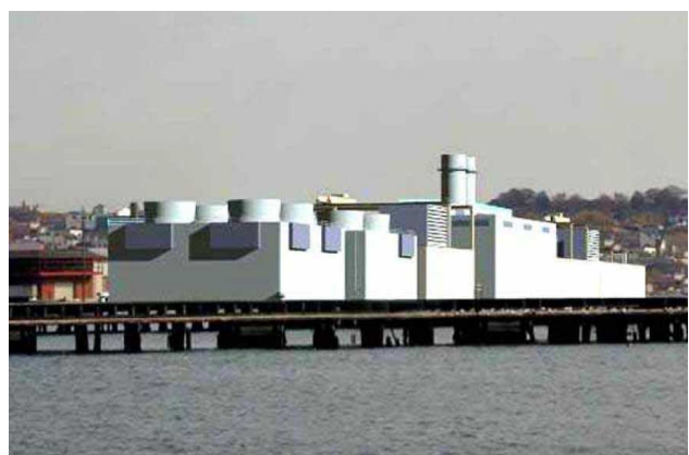
Rys. 5. Koncepcja elektrowni na barce pływającej o mocy 530MW z turbinami gazowymi GE 7FA. Źródło: [2,7].
