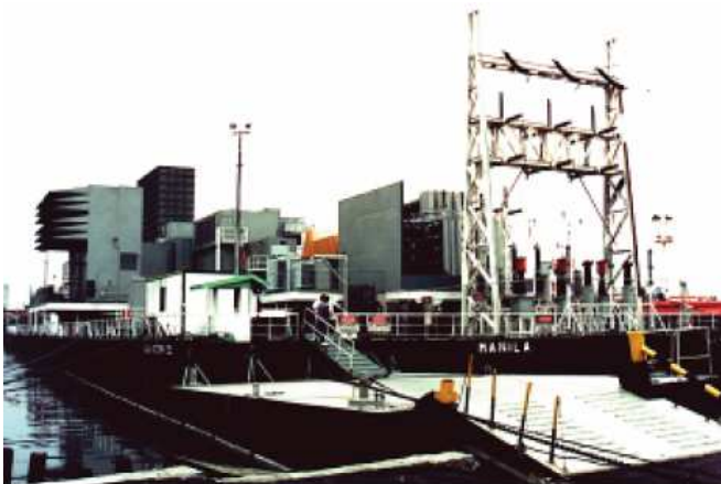
Rys. 4. Elektrownia na barce pływającej „Manila” o mocy 105MW z turbinami gazowymi Westinghouse 501. Źródło: [2].
