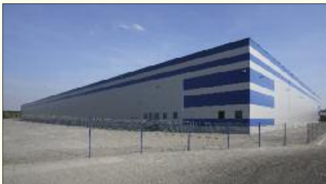
Point Park Mszczonów – przykład nowoczesnego obiektu magazynowego (fot. Euro RSCG Sensors).
