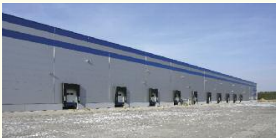
Point Park Mszczonów – doki przeładunkowe na jednej ze ścian magazynu (fot. Euro RSCG Sensors).
