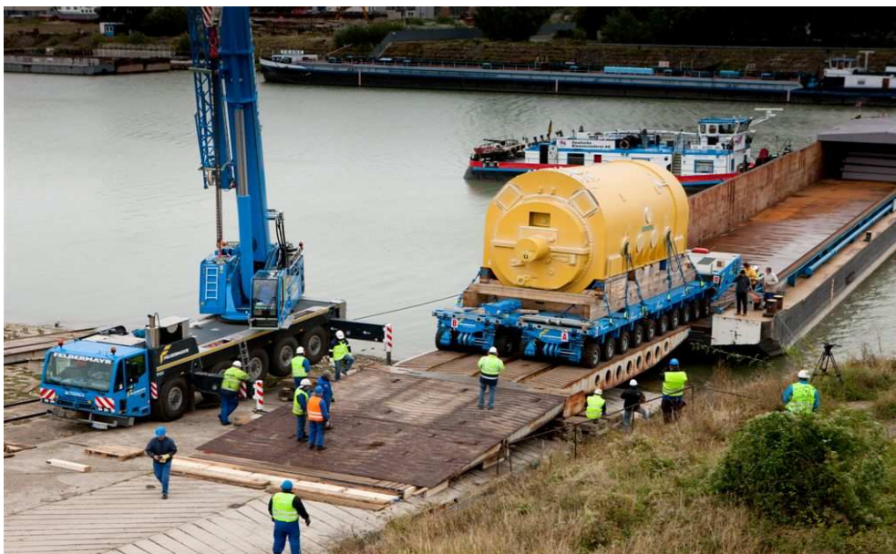
Rys. 2 Wyladunek generatora SIEMENS z barki specjalnej typu RO-RO „DRIVE IN“
