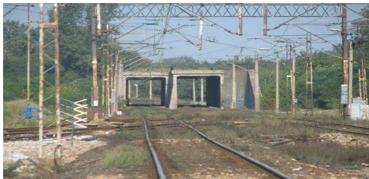
Rys.2 Stacja W-wa PRAGA rejon WPD przed przebudową we wrześniu 2007. Wiadukt skrzynkowy w km 13.400 do wyburzenia [źródło: opracowanie własne]
