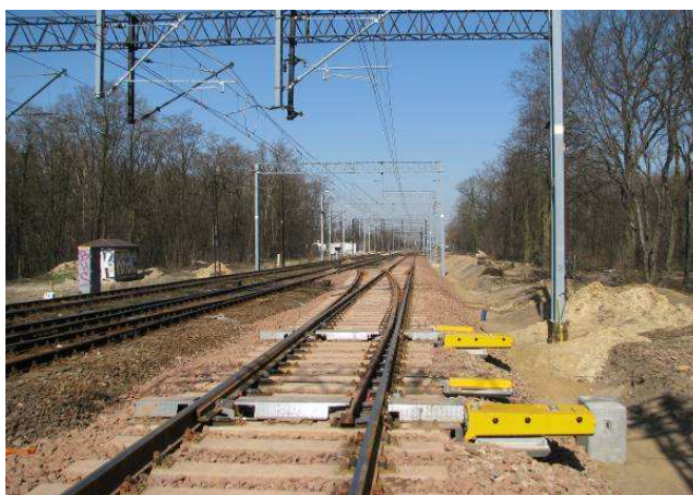
Rys. 11 Nierozpruwalne napędy rozjazdowe EA5 firmy BOMBARDIER [źródło: opracowanie własne]
