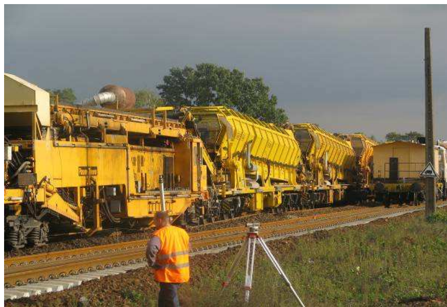
Rys. 8 Obsługa geodezyjna AHM i widoczna linka retencyjna
