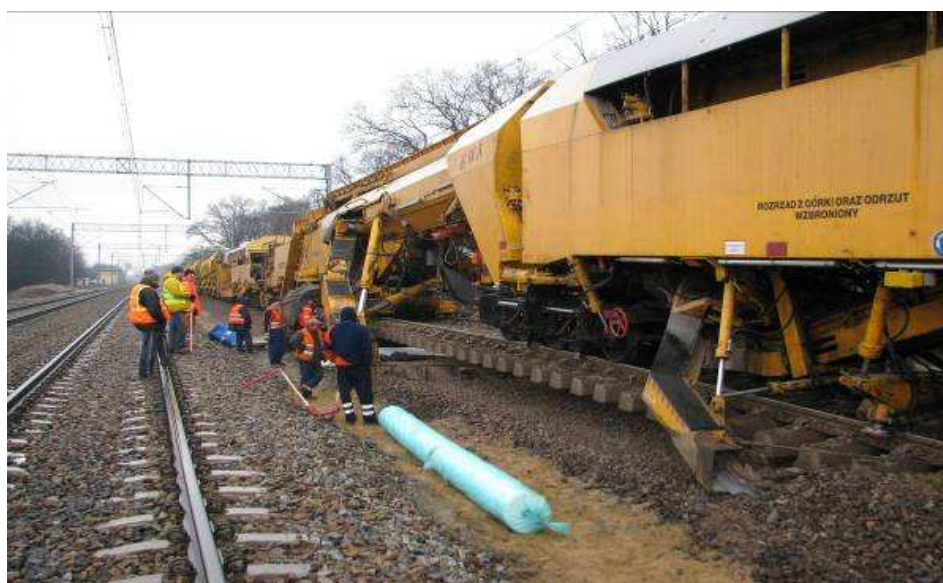
Rys. 2 Łańcuch wybierający tłuczeń
