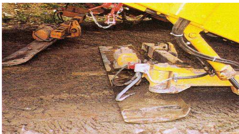
Rys. 5 Wibratory stabilizują koronę torowiska (źródło: PKP PLK S.A. Zakład Maszyn Torowych w Krakowie)
