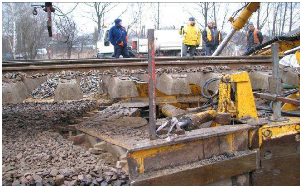
Rys. 3 Łańcuch wybierający warstwę podtorza
