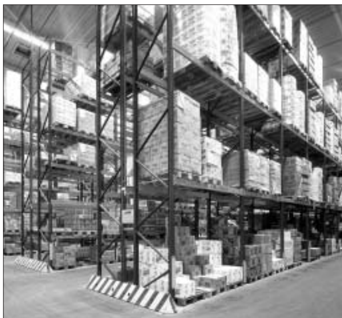
Ryc. 1. Tradycyjny regał paletowy z progiem ochronnym przed uderzeniem wózkami podnośnikowymi widłowymi w słupy regału. Próg zamocowany bezpośrednio do posadzki z pominięciem regału.
