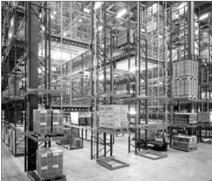
Ryc. 13. Przykład regału paletowego o wąskich drogach manipulacyjnych i z pomostami obsługowymi do kompletacji usytuowanymi jeden nad drugim
