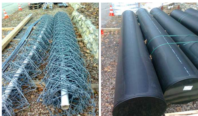
Rys. 3 - 4. Siatka oraz pływaki testowanej bariery FOXX
