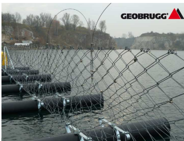
Rys. 13. Uszkodzenia siatki tworzącej barierę FOXX po przeprowadzonych próbach
