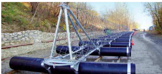
Rys. 5. Sekcja podstawowa bariery FOXX po zmontowaniu
