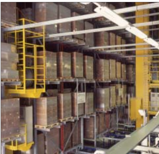
Rys. 3. Wnętrze Centrum Logistycznego BLG International Logistics w Bremie. Źródło: Internet
