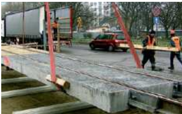
Rys.7. Nawierzchnia bezpodsypkowa typu ERS piątej generacji [2]
