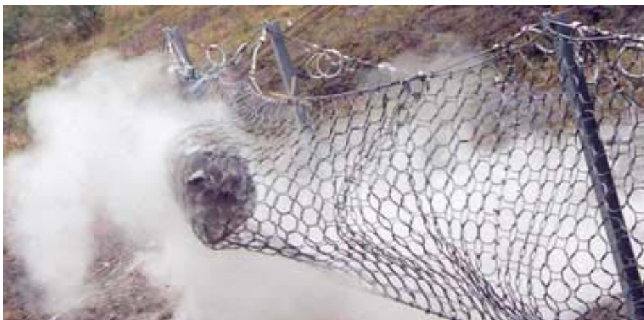
Rys. 2. Bariera wychwytyjąca odłamki skalne
