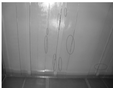
Rys.1. Ogólny widok fragmentu konstrukcji płyty dolnej generatora.
