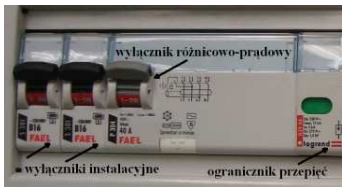
Rys.1. Rozmieszczenie zabezpieczeń instalacji samochodowej 230 V
