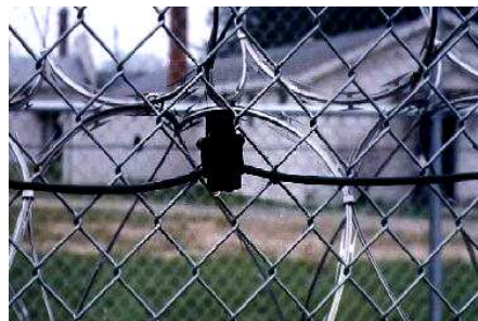
Rys. 4 Układ systemu R.B. TEC IA 5500W wraz z przykładowym zamocowaniem sensora
