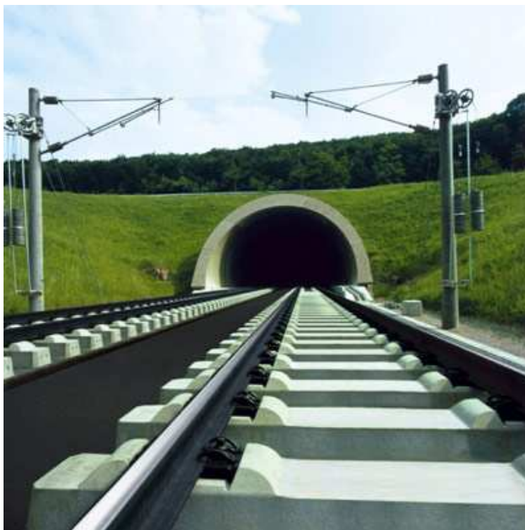
Fot. 2. Przykład torowiska z systemem warstw asfaltowych Getrack w Niemczech
