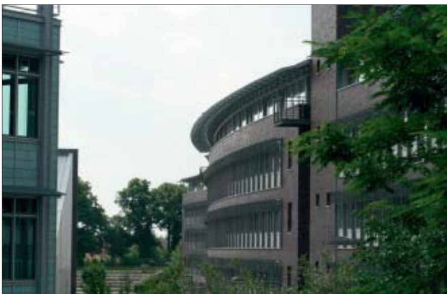
Fragment budynku HSL (fot. autor).
