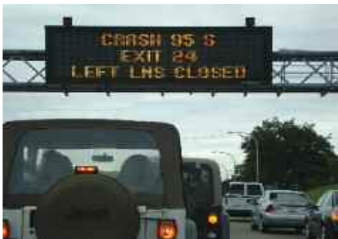
Fot. 2. Komunikaty generowane automatycznie lub wpisywane przez operatora wyświetlane są w czasie rzeczywistym na znakach zmiennej treści. Źródło: zdjęcie wykonane przez autora.
