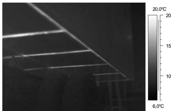
Rys. 5. Zdjęcie termowizyjne podłogi – widoczne wzmocnienia [1]
