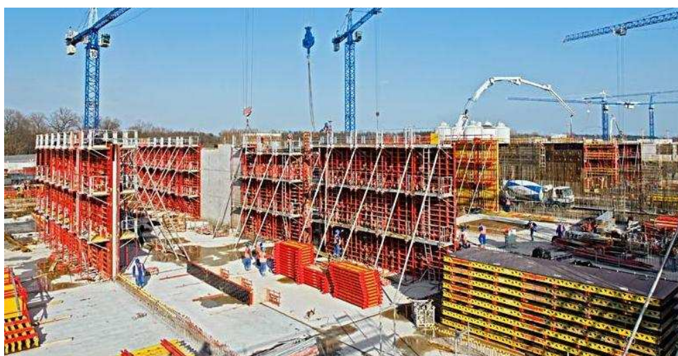
Fot. 1 Przykład deskowania inwentaryzowanego ( www.peri.pl.pl )
