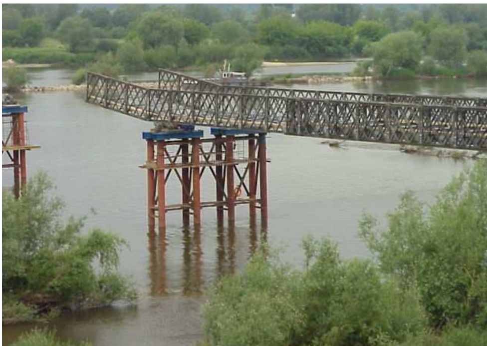
Fot. 2 Nasuwania przęsła mostu z konstrukcji składanej (materiały własne)
