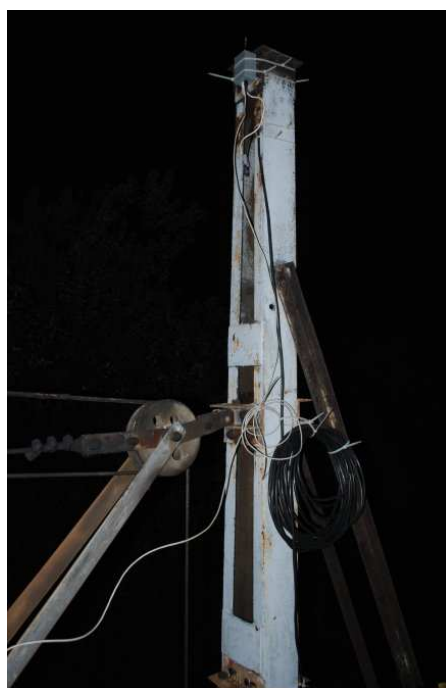
Rys. 8 Prototypowa instalacja na słupie trakcyjnym. [Źródło: Opracowanie własne.]
