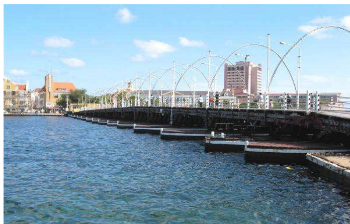
Rys.9. Widok na pontonowy most Królowej Emmy [11]
