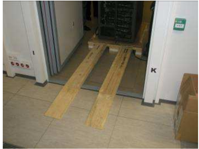
Rys. 2. Przygotowanie najazdów na próg
