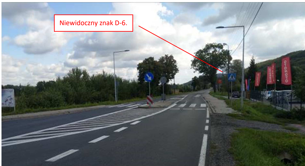
Zdjęcie 7 Źle widoczne oznakowanie pionowe.
