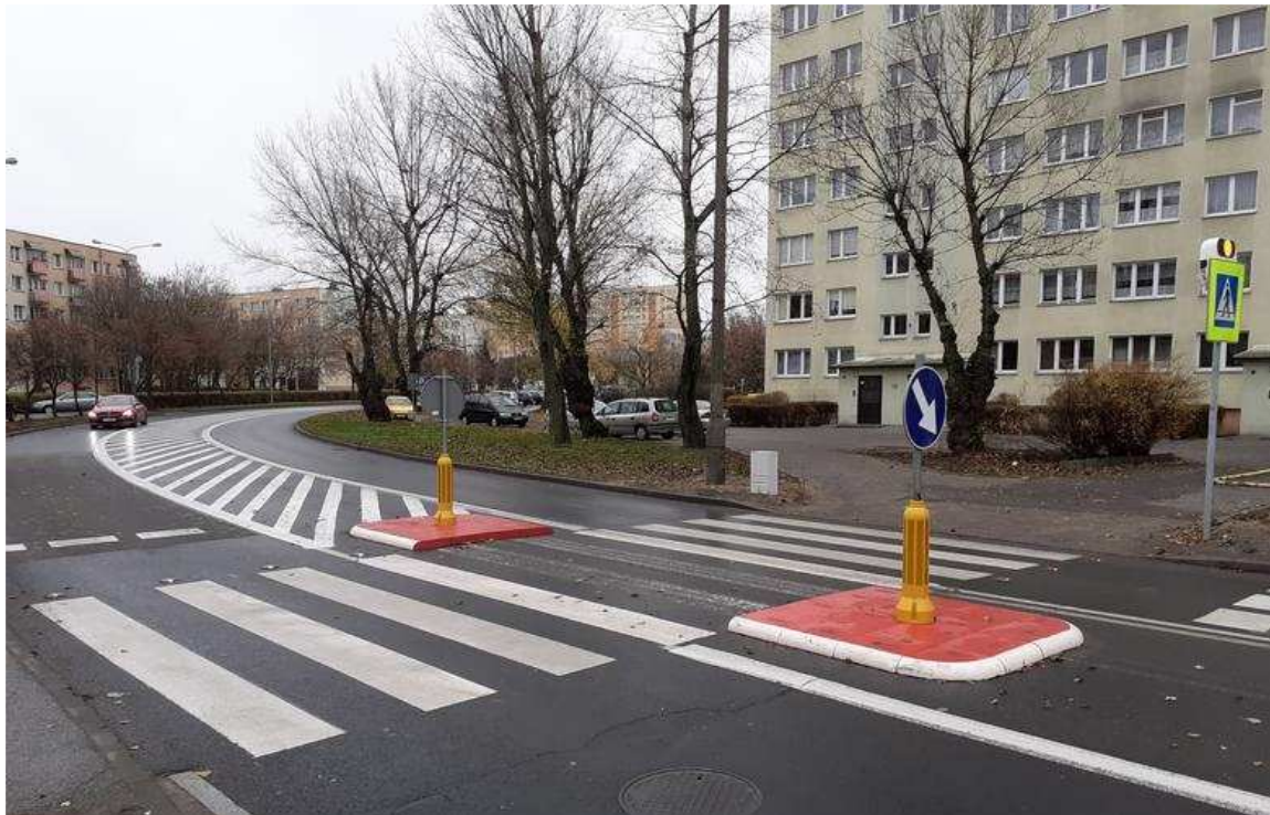
Zdjęcie 10 Przykłady zastosowania NOPWT Toruń ul. Rydygiera https://d-pt.ppstatic.pl/k/r/1/ae/71/5df09d25a385b_p.jpg?1576050010
